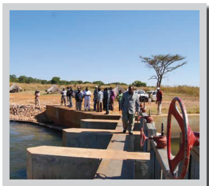
Obras hidráulicas em Menongue, Angola
